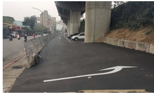
圖 3-5 新北三重區停車場完工現場
